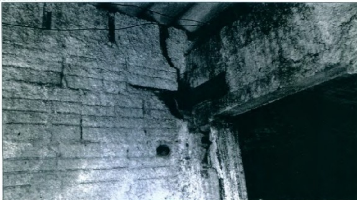
Foto 10. Detalhe de conservação da edificação. Registro efetuado em 06/07/2017.
