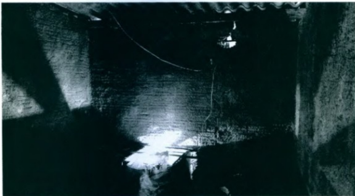
Foto 11. Detalhe de conservação da edificação. Registro efetuado em 06/07/2017.
