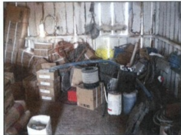
Fotos: Visão interna de um dos depósitos de agrotóxicos, com frestas nas paredes, entre elas e o telhado, e ausência de sistema adequado de ventilação.
