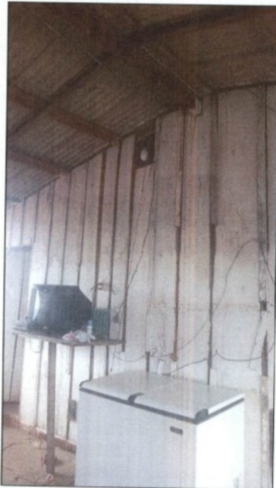
Fotos: Circuitos elétricos desprotegidos e com risco de choque, encontrados na Fazenda.
