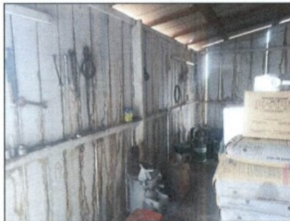
Fotos: Visão interna de um dos depósitos de agrotóxicos, com frestas nas paredes, entre elas e o telhado, e ausência de sistema adequado de ventilação.
