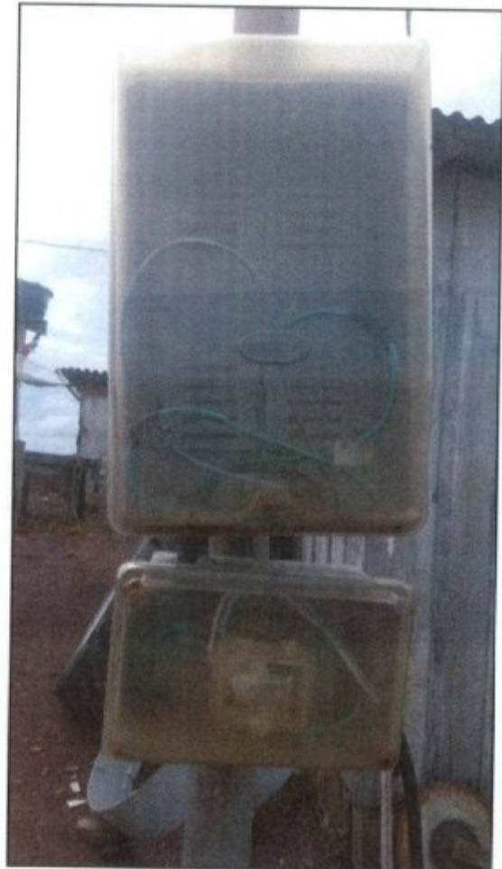
Fotos: Circuitos elétricos desprotegidos e com risco de choque, encontrados na Fazenda.
