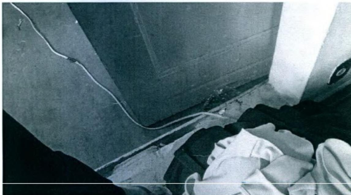
oficina de costura: fiação elétrica fora de conduítes em contato com material inflamável.
