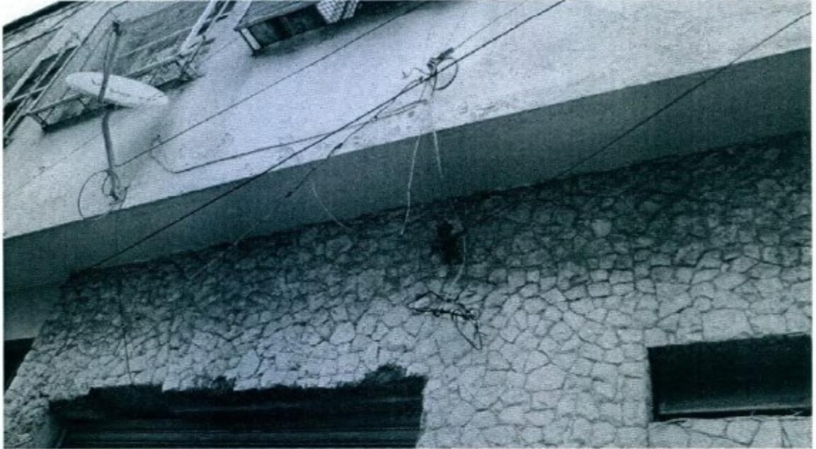
parte externa do imóvel que abriga a oficina: fiação elétrica improvisada com emendas e "gambiarras".
