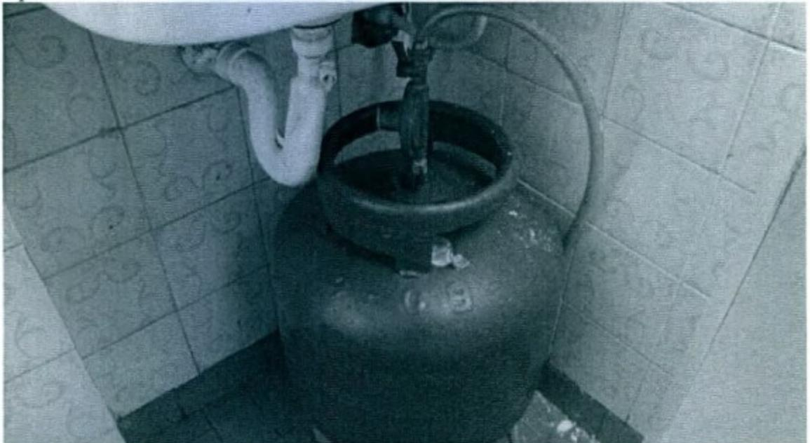
Botijão de GLP (gás liquefeito de petróleo) estocado em local fechado e sem ventilação. Risco de explosão.
