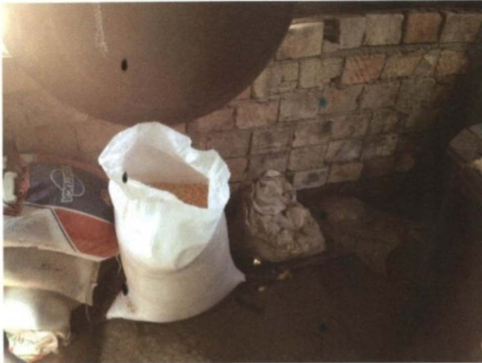
Sacos contendo milho, sal e adubo, acondicionados no chão do paiol utilizado como alojamento. - Foto tirada pelo AFT [REDACTED] em 12/01/2017.
