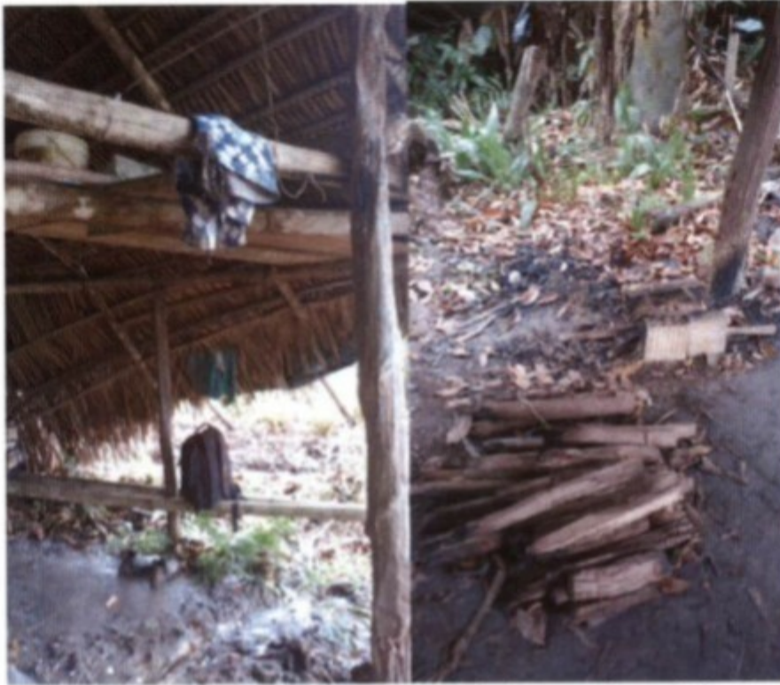
Fotos 13 e 14: parte interna do barraco destinado à alojamento dos trabalhadores e local utilizado para cozimento de refeições.
