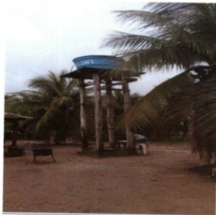
Foto 04: Caixa de água.
