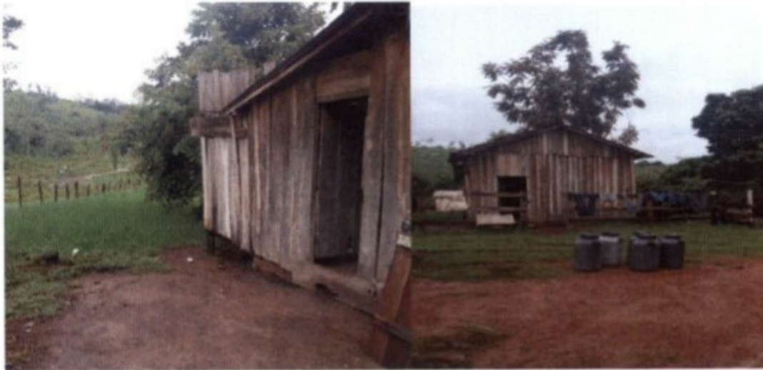
Fotos 1 e 2: Residência destinada ao trabalhador.
