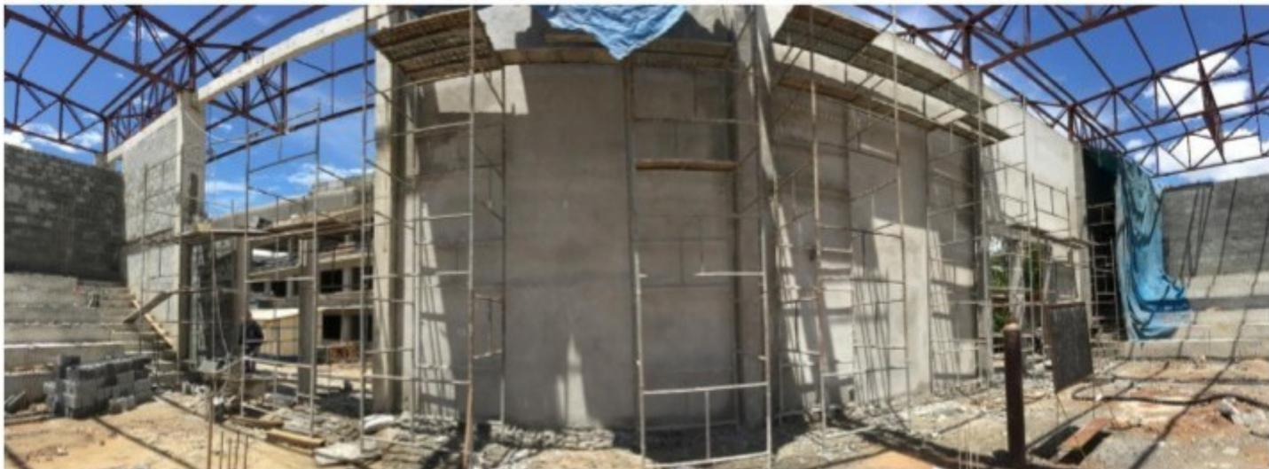
**24/01/2017 - CANTEIRO DE OBRAS da construção da ETEC e FATEC de Guarulhos, situado na Rua Cristobal Claudio Elilo, s/nº, Guarulhos/SP: a empresa utilizou andaime fachadeiro sem cobertura externa por tela de material com resistência mecânica condizente com os trabalhos e/ou que impeça a queda de objetos.**
