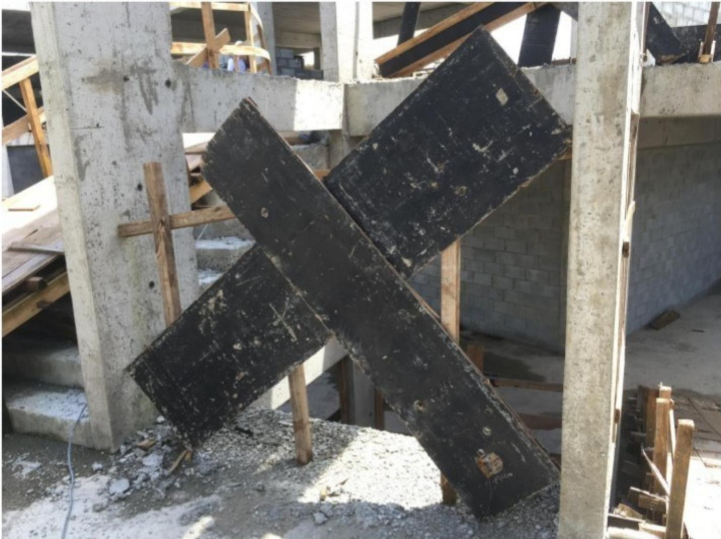
**24/01/2017 - CANTEIRO DE OBRAS da construção da ETEC e FATEC de Guarulhos, situado na Rua Cristobal Claudio Elilo, s/nº, Guarulhos/SP: a empresa deixou de dotar os vãos de acesso às caixas dos elevadores de fechamento provisório constituído de material resistente e seguramente fixado a estrutura ou dotar os vãos de acesso às caixas dos elevadores de fechamento provisório com altura inferior a 1,20 m.**
