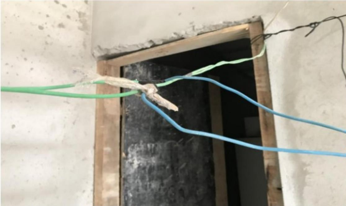
23/11/2017 - Canteiro de obra. Instalações elétricas improvisadas. Endereço: [REDACTED]
