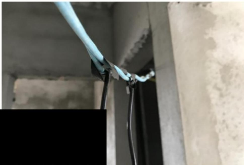
23/11/2017 - Canteiro de obra. Instalações elétricas improvisadas. Endereço: Av [REDACTED]
