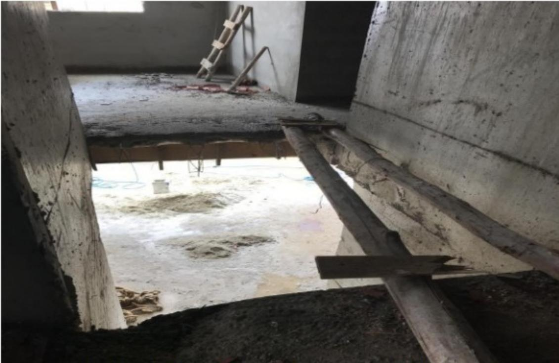
23/11/2017 - Canteiro de obra. Abertura de piso (caixa de elevador sem fechamento), no 2º pavimento, sem proteção. Endereço: [REDACTED]
