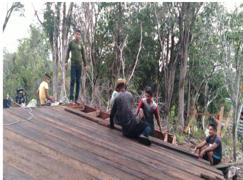
Construção de base de monitoramento de quelônios no baixo rio Marmelos (AM). Foto: Coram/Funai
