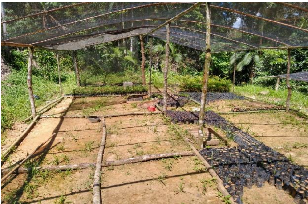
Construção de viveiro de mudas na TI Guarani do Bracuí (RJ).
