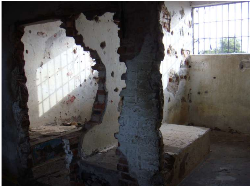
Interior da cela interdita do Pavilhão "C" do PCPA
