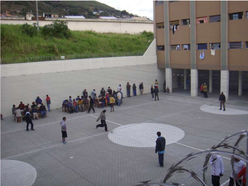
Pátio do novo pavilhão do PCPA
