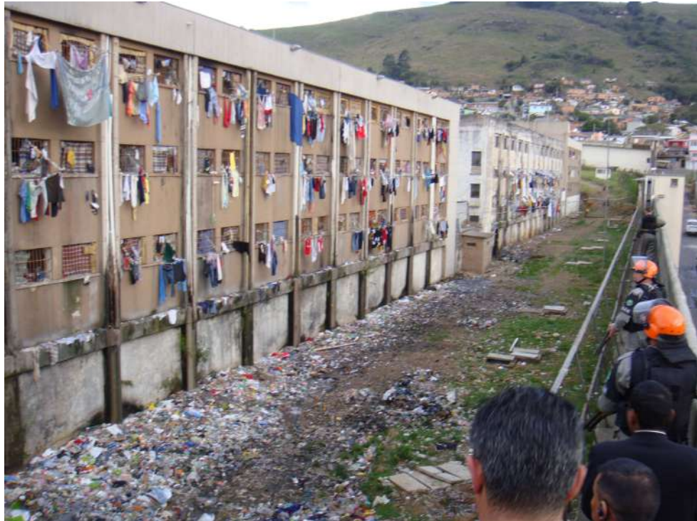
Lixo entulhado ao lado do pavilhão
