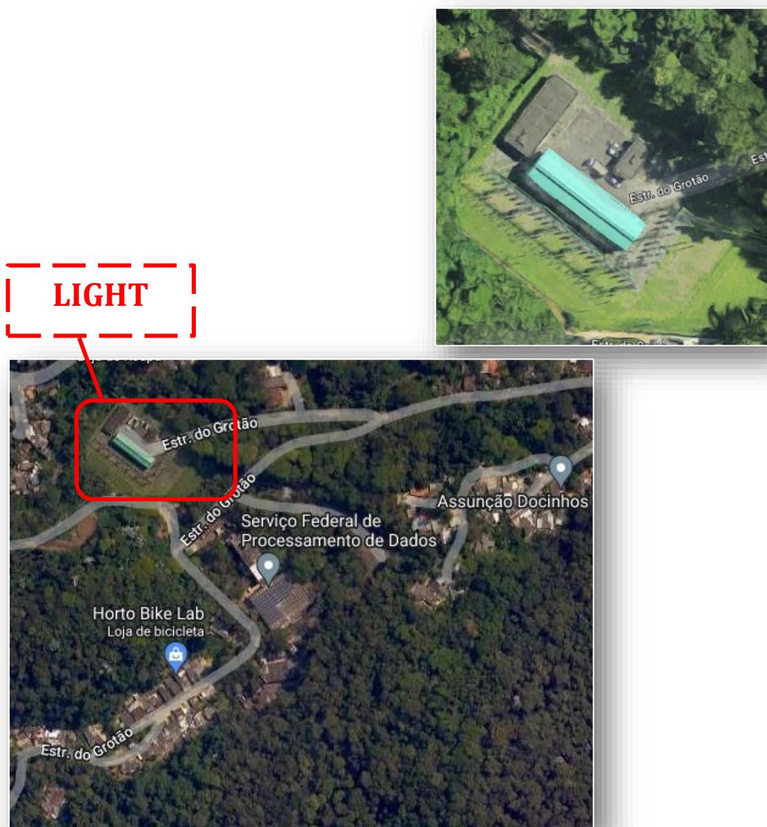
MAPA 10 - SUBESTAÇÃO DA LIGHT ENERGIA
