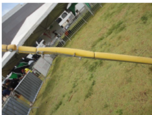
Figura 5 e 6 Cabo de aço com proteção com macarrão de piscinas.
