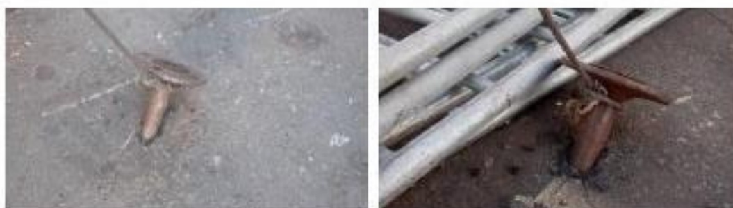
Figura 9 e 10 Cabo de aço amarrado.
