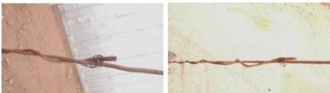
Figura 11 e 12 Cabo de aço amarrado com arame.
