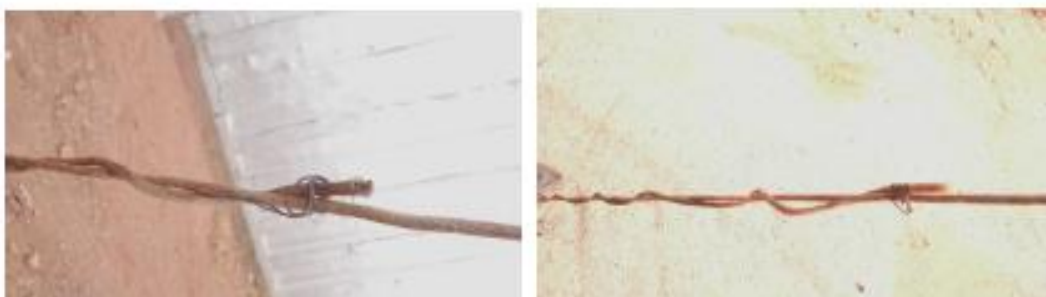
Figuras 11 e 12 Cabo de aço amarrado com arame.
