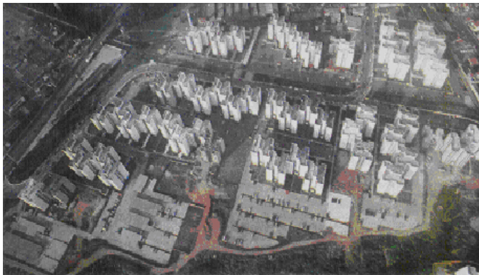
Foto V-1: Visão geral do Conjunto Residencial Barão de Mauá
