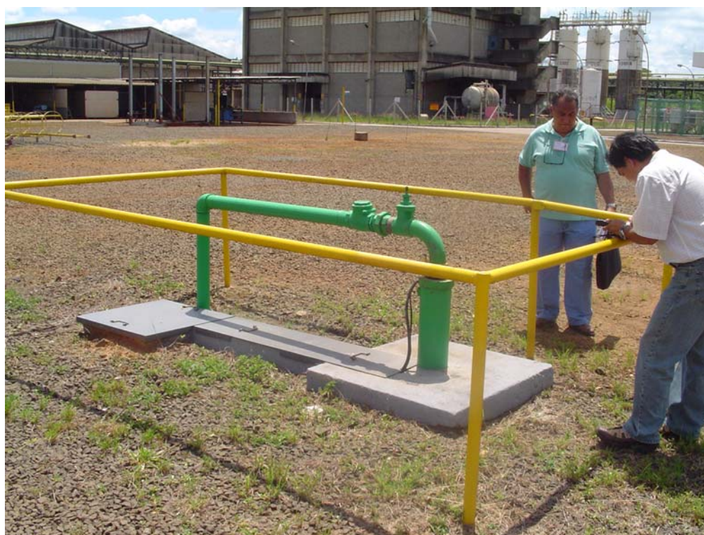
Foto 4: Registro fotográfico do Poço 4
