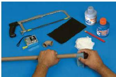
FIGURA 9 - EXECUÇÃO DE JUNTA SOLDÁVEL
