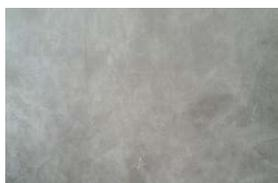
O piso de concreto poderá ser obtido através do desenvolvimento: sarrafeamento e alisamento da própria camada de concreto, traço 1:3:4 (cimento, areia grossa e pedra britada) com 7 cm de espessura. Após nivelamento, desempenar e queimar. Utilizar desmoldante em pó após a queima em toda a área a ser estampada. Obedecer a um intervalo de 24 horas sem qualquer tráfego.
