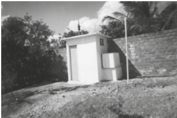
Privada com Fossa Absorvente
