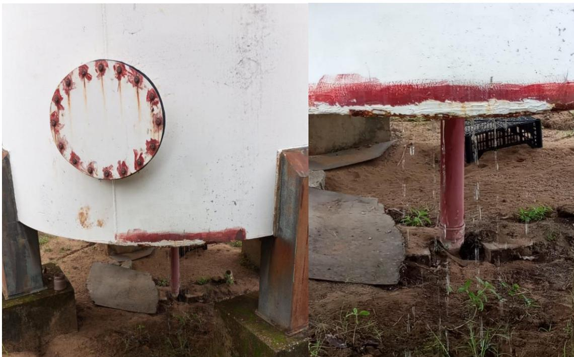
**Figura 07:** Vazamento no reservatório metálico aldeia Camurupim
