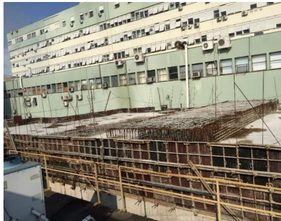
Foto 2: Vista superior da obra de construção do bunker no HUSM
