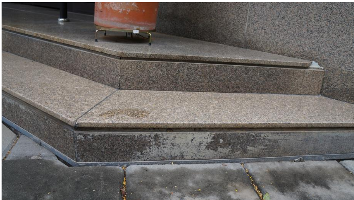
Foto 02 – Escada na entrada da secretaria
