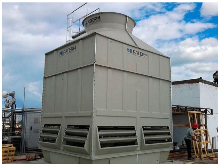
Figura 6 - Torre de Resfriamento. Fonte: http://www.alfaterm.com.br/torre-resfriamento-ar-condicionado
