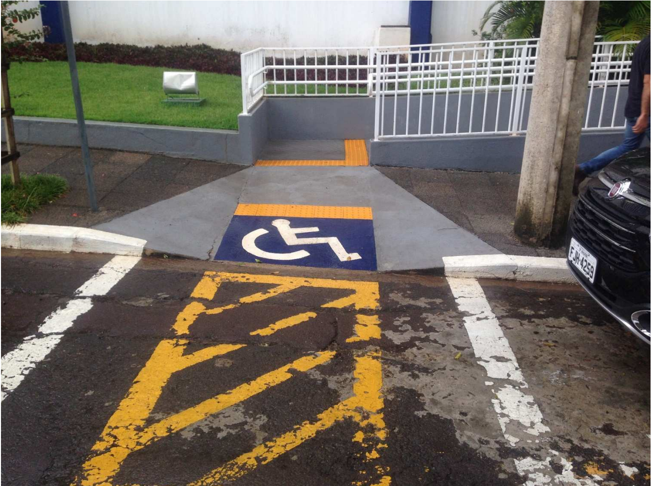
Figura 4 - Rampa de acesso
