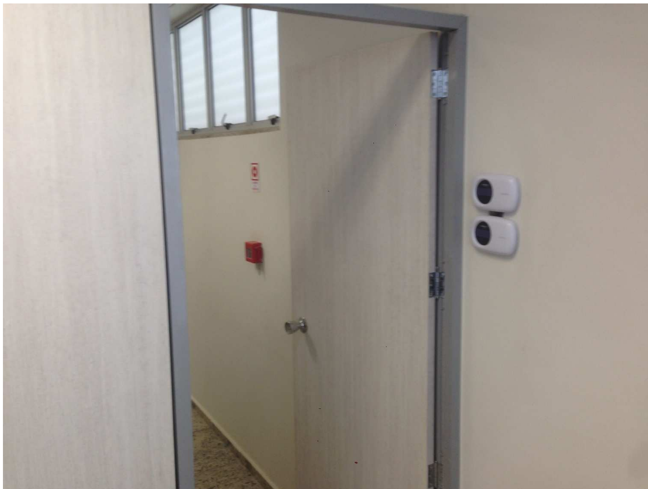
Figura 11 – Vista das portas das salas administrativas.
