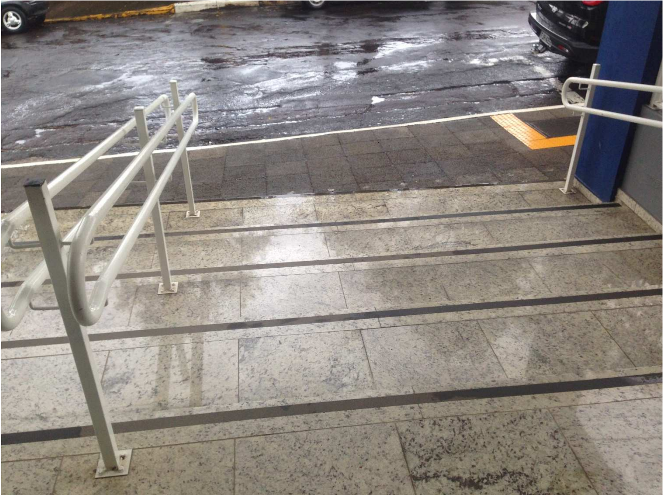
Figura 5 – Vista da escada de acesso.
