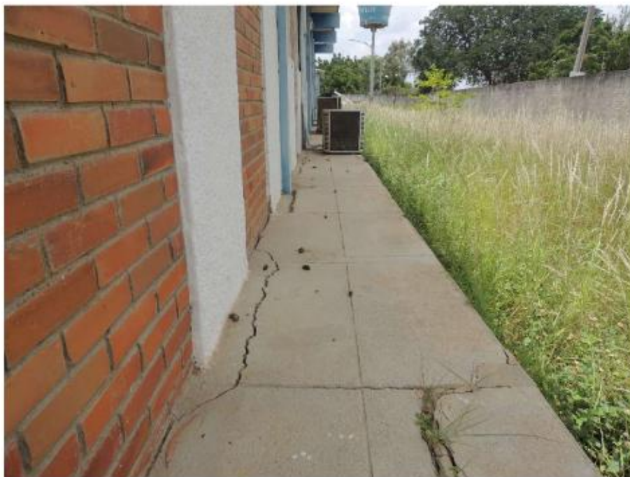
Figura 10. Rachaduras na passarela externa próximas ao pilar
