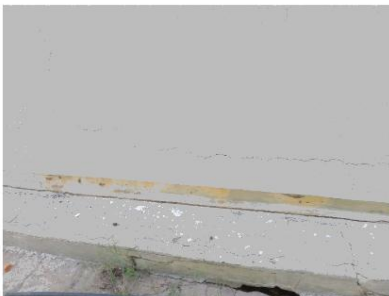
Figura 5. Fissuras horizontais na fachada
