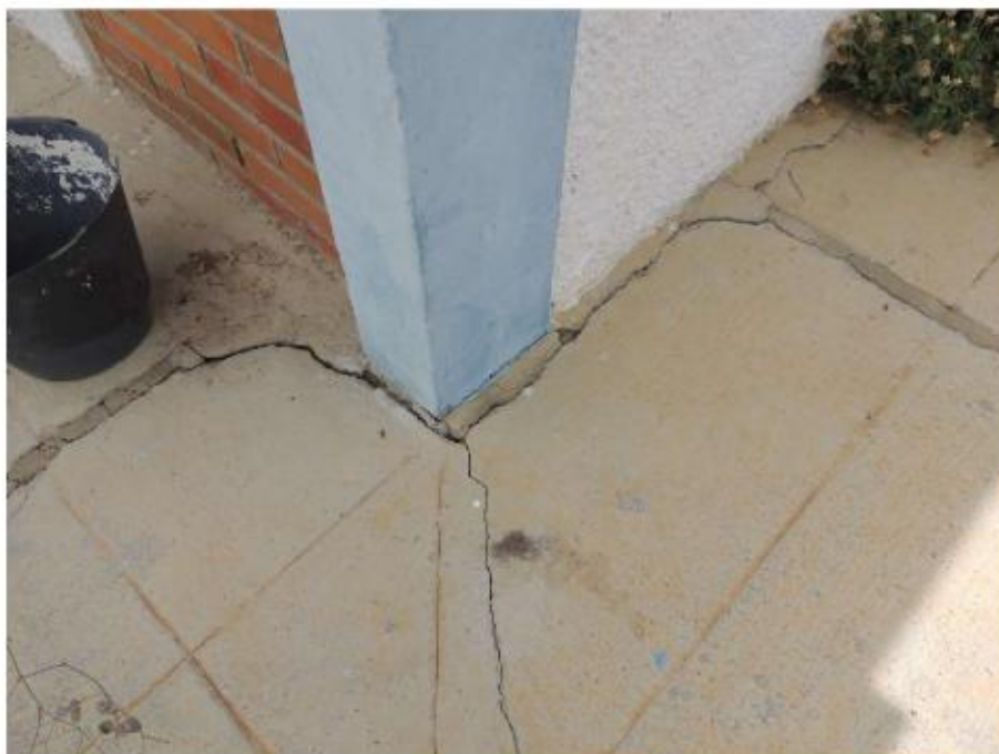
Figura 10. Rachaduras na passarela externa próximas ao pilar
