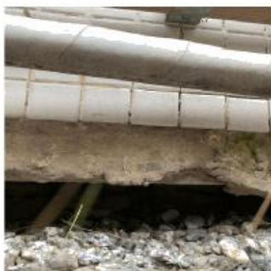
Foto n.14 – Rebaixamento do solo
