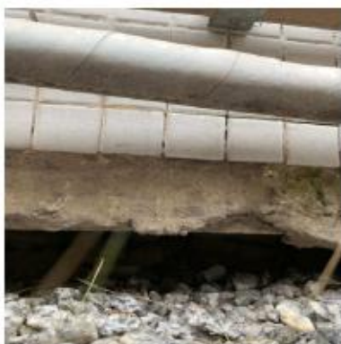
Foto n.14 – Rebaixamento do solo
