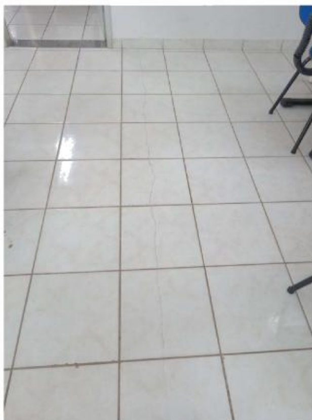
Figura 12. Fissura do piso interno
