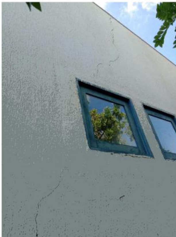
Figura 6. Fissuras diagonais na fachada
