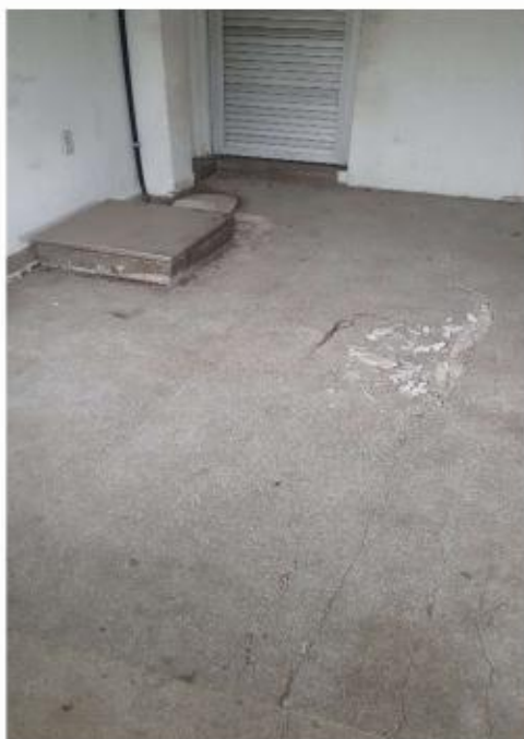
Figura 15. Detalhe do afundamento e rachaduras ao redor do reservatório
