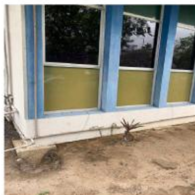
Foto n.15 – Rebaixamento do solo
