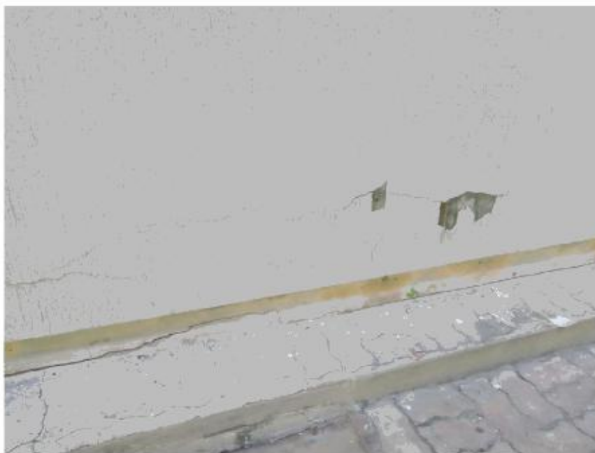
Figura 5. Fissuras horizontais na fachada
