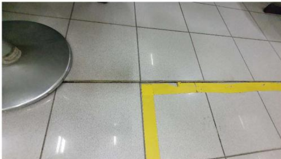
Figura 16. Afundamento do piso próximo ao reservatório
