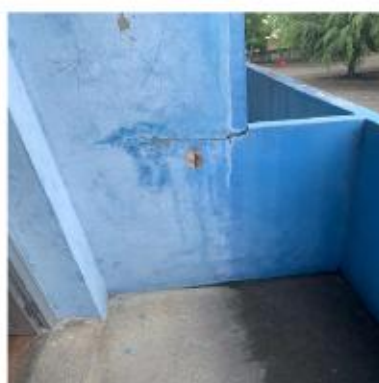
Foto n.26 – Fissura Varanda
