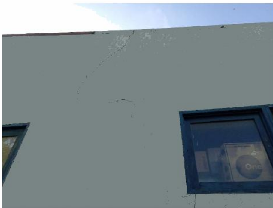
Figura 7. Fissuras verticais na fachada
