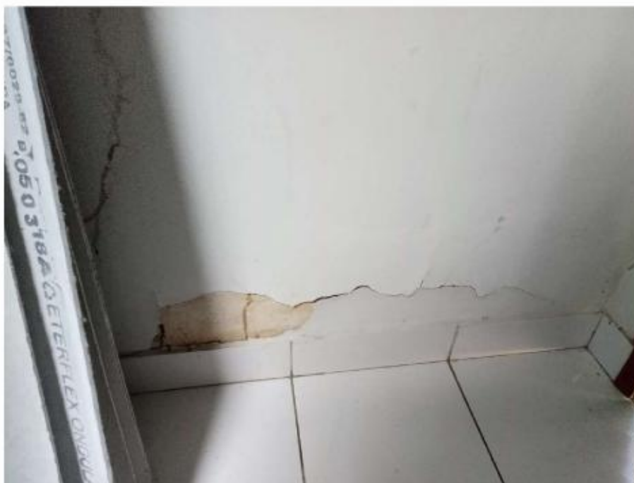
Figura 8. Fraturas horizontais no lado interno da alvenaria da fachada
