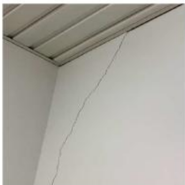
Foto n.4 – Trinca parede Sala Motorista
