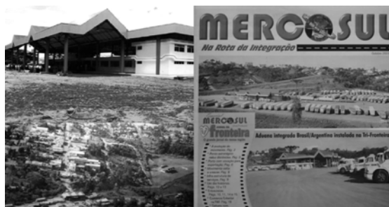
À esquerda, construção da Aduana de cargas (acima) e comércio realizado ainda pela Aduana de turismo, durante o período de obras (abaixo); à direita, edição especial do Jornal da Fronteira, em 2003.
