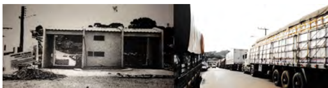
Construção em 1978 (esquerda) e movimento de cargas (direita), na Aduana de turismo. Fonte: Acervo de "Nei" Schlichting (esquerda) e do Jornal da Fronteira (direita)
