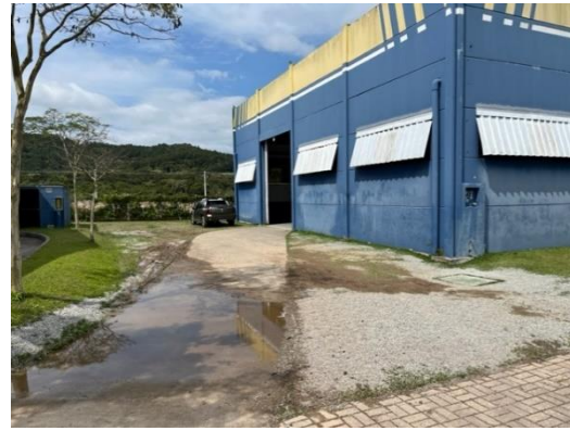
Figura 22 - Acesso ao hangar.
