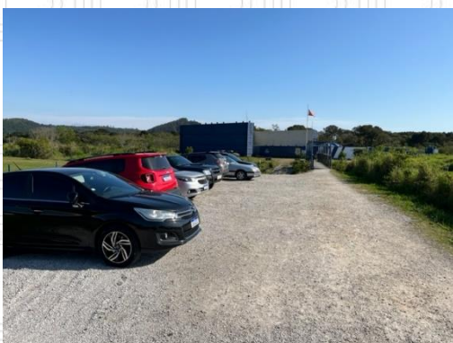
Figura 9 - Rota interna sem pavimentação definitiva.
