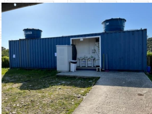
Figura 39 - Contêiner banheiro - stand de tiros.
