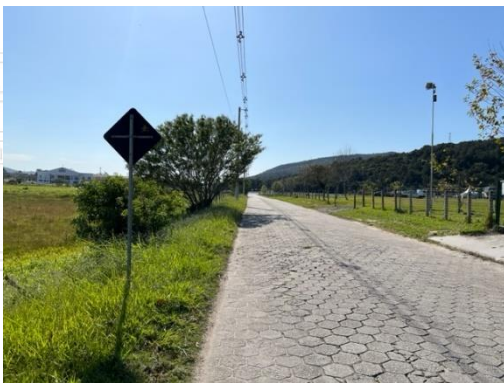
Figura 6 - Logradouro da entrada para o hangar
