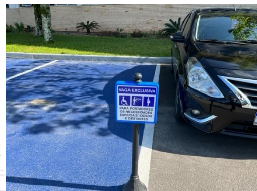
Figura 16 - Vagas reservadas com sinalização em desconformidade com a norma.
