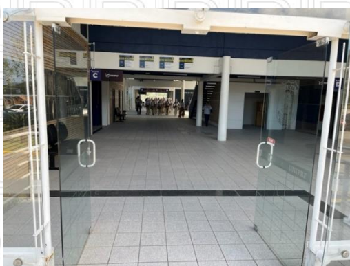
Figura 18 - Acesso à edificação principal.
