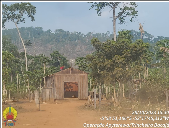
Casa sendo desmontada
