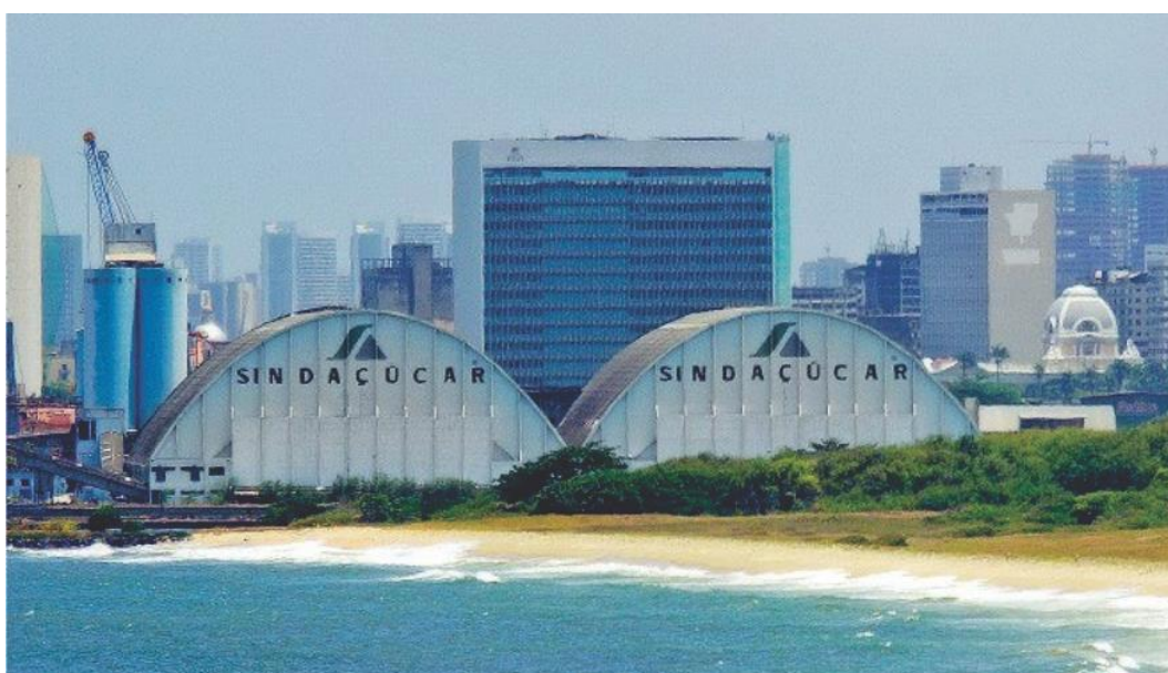
Figura 4. Silos Horizontais do Terminal de Açúcar e Melaço
