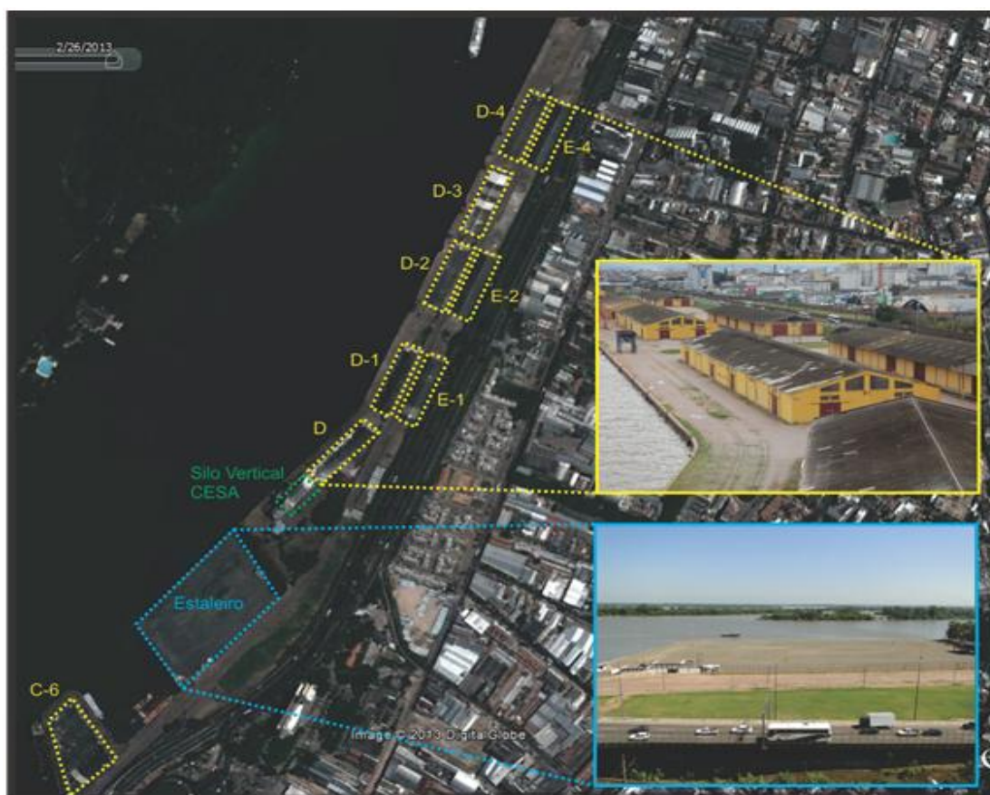
Figura 3. Armazéns, Silo Vertical e Estaleiro
