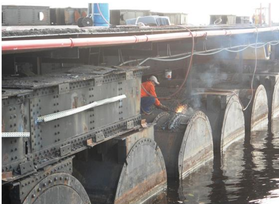
Figura 1. Soldagem nos Flutuantes
