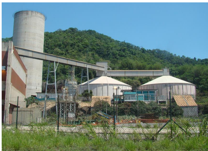
Figura 2. Silos do Terminal de Alumina
