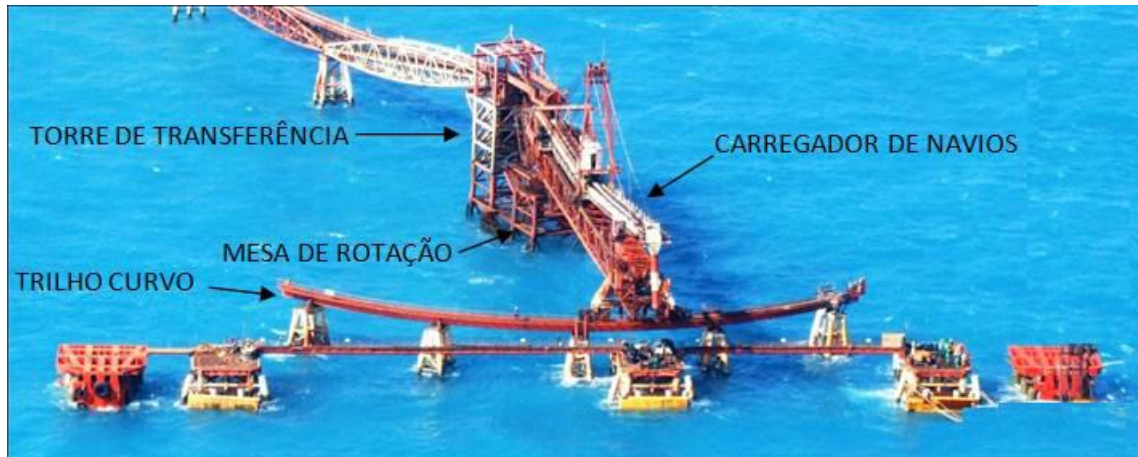
Figura 9. Estruturas e Equipamentos Utilizados na Movimentação de Sal
