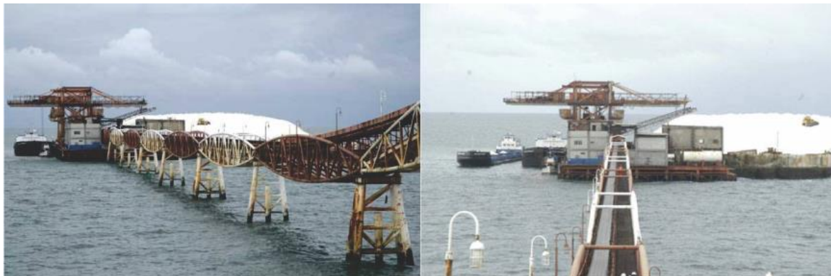
Figura 8. Esteira Transportadora e Estrutura de Sustentação do Terminal Salineiro de Areia Branca
