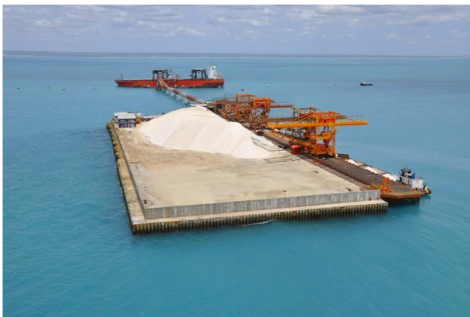
Figura 5. Pátio de Armazenagem de Sal do Terminal Salineiro de Areia Branca
