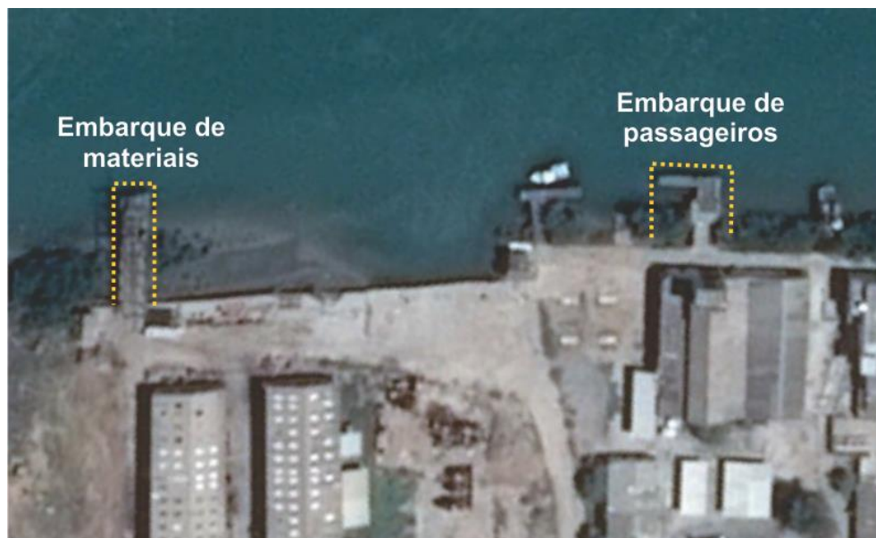
Figura 3. Estrutura de Acostagem na Porção Terrestre do Terminal
