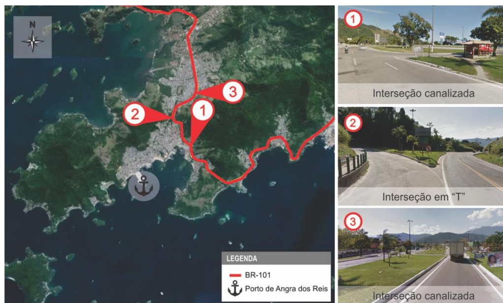
Figura 8. Pontos Críticos BR-101 – RJ
