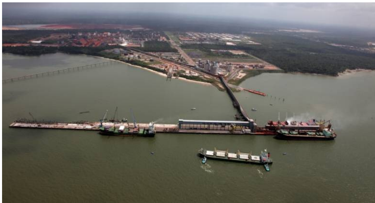
Foto 1 - Ampliação em execução no Porto de Vila do Conde/PA
