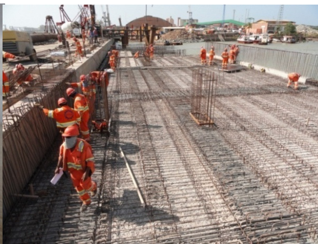
Foto 5 - Porto de Itaqui/MA - Alargamento do Cais Sul
