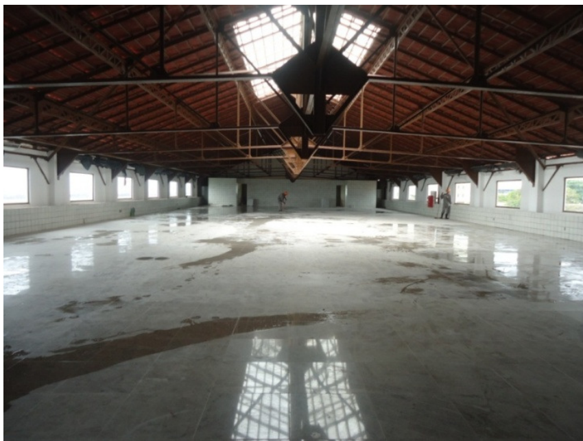
Foto 12 - Armazém 7 (pavimento superior)
