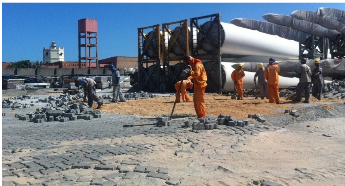
Foto 3 - Detalhe da pavimentação do Terminal de Contêineres do Porto de Fortaleza/CE
