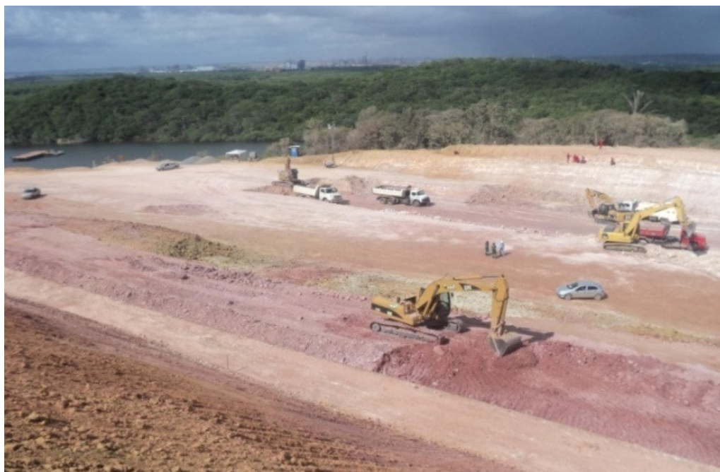
Foto 10 - Serviço de Terraplenagem
