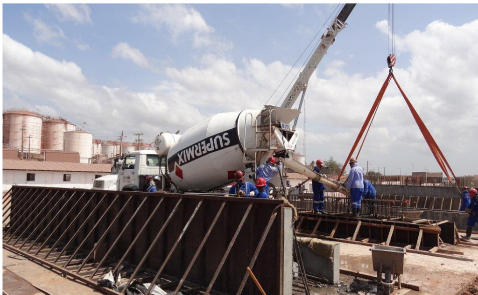
Foto 7 - Porto de Itaqui/MA – Concretagem de pré-moldados
