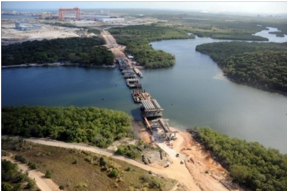
Foto 9 - Ponte rodoviária sobre o Rio Massangana
