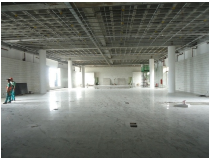
Foto 11 - Vista interna do Armazém 7 (pavimento térreo)
