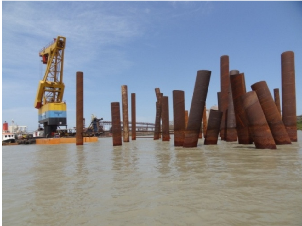
Foto 6 - Porto de Itaqui/MA - Cravação de camisas metálicas
