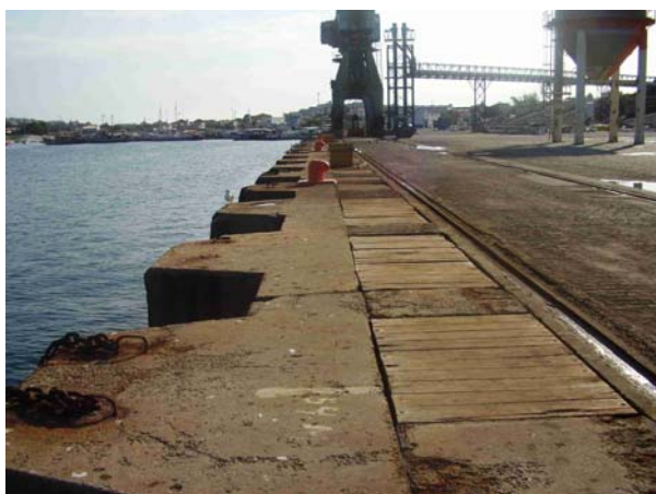
FIG 4 – DETALHE DO PARAMENTO DO CAIS
