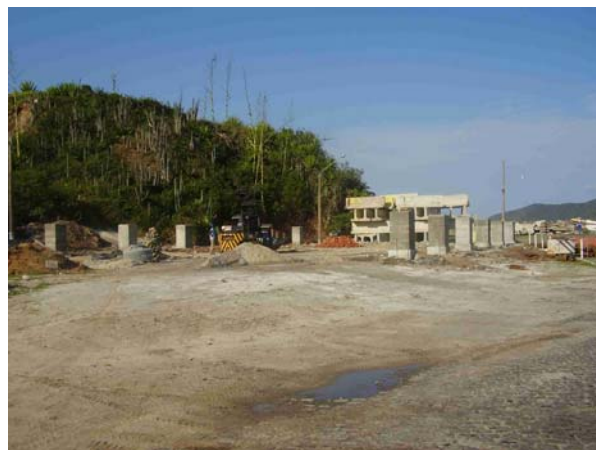
FIG 9 – GALPÃO EM CONSTRUÇÃO
