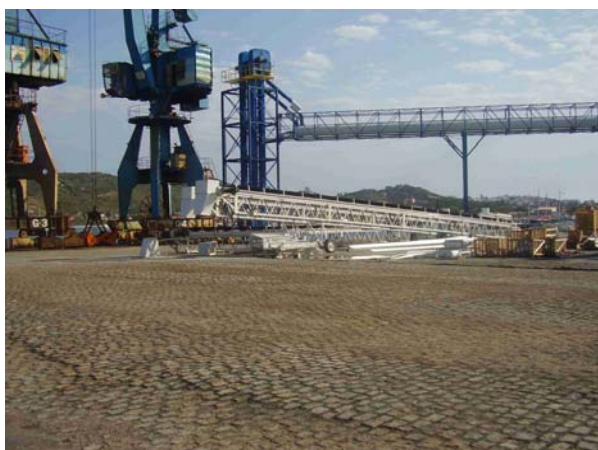
FIG 19 E 20 – ESTRUTURAS DAS CORREIAS TRANSPORTADORAS MÓVEIS (EM MONTAGEM NO CHÃO), CORREIA TRANSPORTADORA FIXA, ELEVADOR, GUINDASTES E MOEGAS NO CAIS.
