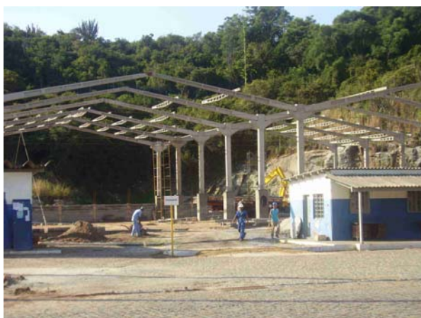
FIG 8 – ARMAZÉM ALFANDEGADO EM CONSTRUÇÃO
