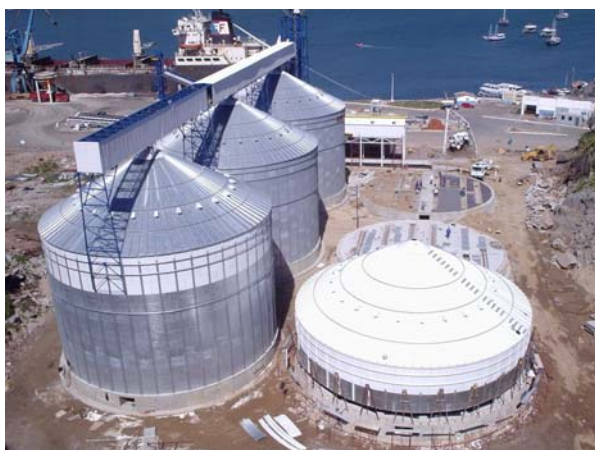
FIG 6 E 7 – SILOS EM CONSTRUÇÃO
