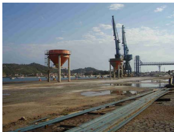
FIG 19 E 20 – ESTRUTURAS DAS CORREIAS TRANSPORTADORAS MÓVEIS (EM MONTAGEM NO CHÃO), CORREIA TRANSPORTADORA FIXA, ELEVADOR, GUINDASTES E MOEGAS NO CAIS.
