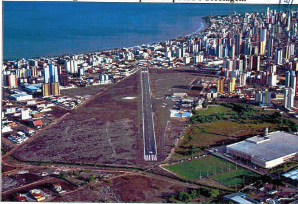
Imagem 2: Visão da pista de pouso e decolagem
