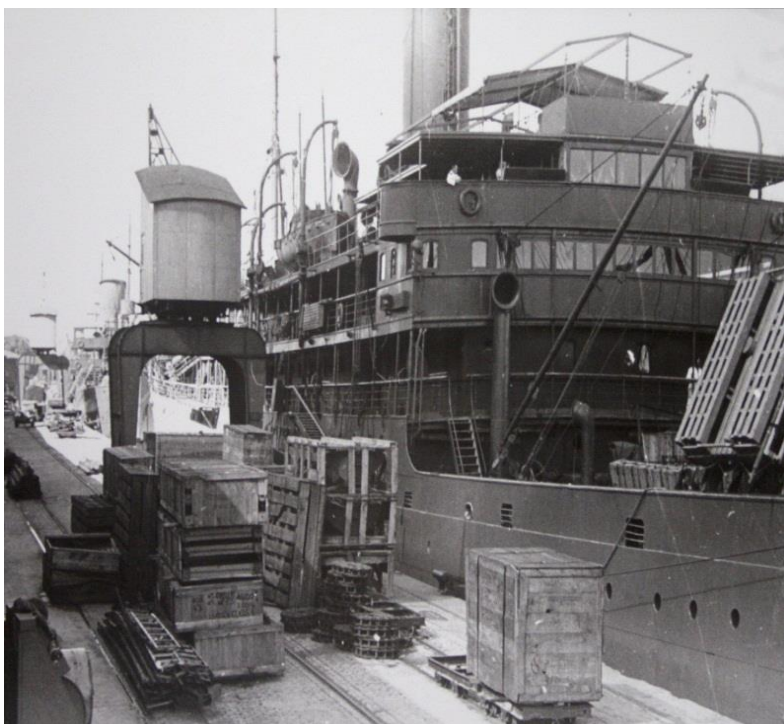
Figura 3.2.1- Movimentação de pessoas e cargas no antigo Porto de Belém (CDP).
