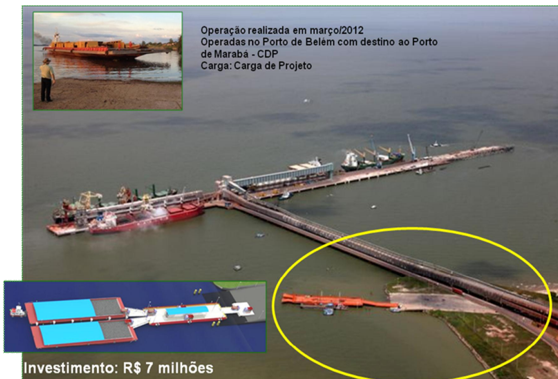
Figura 17 - Terminal Hidroviário de Cargas no Porto de Vila do Conde Fonte: Companhia Docas do Pará (2012)
