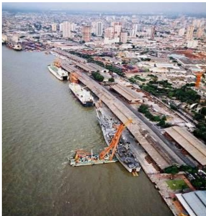
Figura 5 - Berços de Carga Geral do Porto de Belém Fonte: Companhia Docas do Pará (2012).
