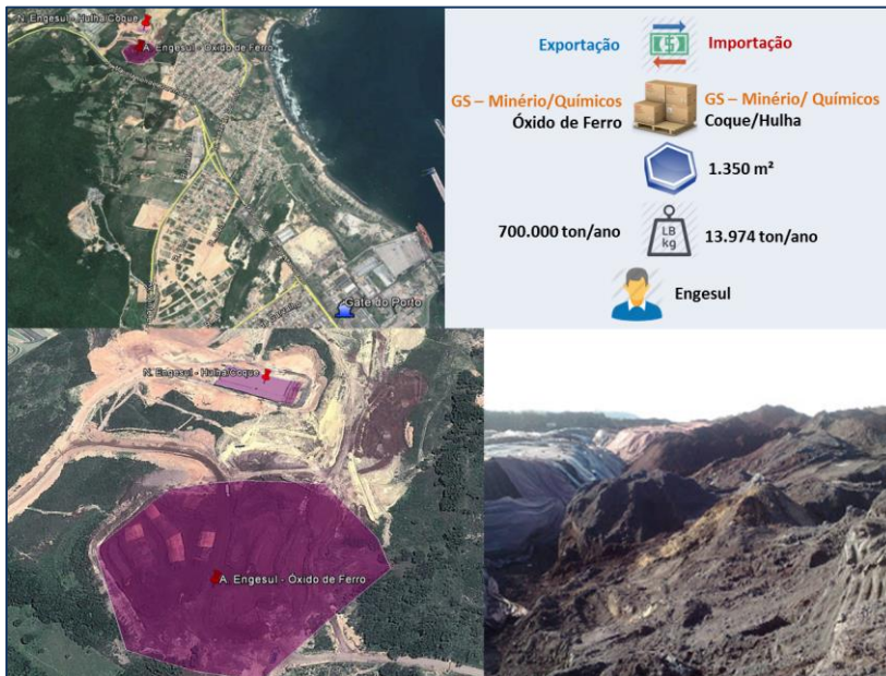
Figura 18 – Armazenagem de óxido de ferro e coque/hulha - Engesul
