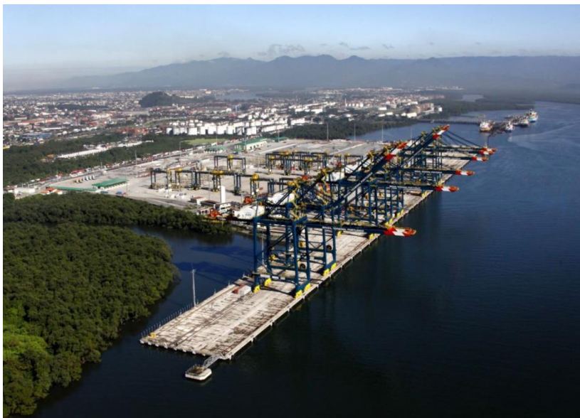
Figura 20 – BTP – Visão do Terminal
