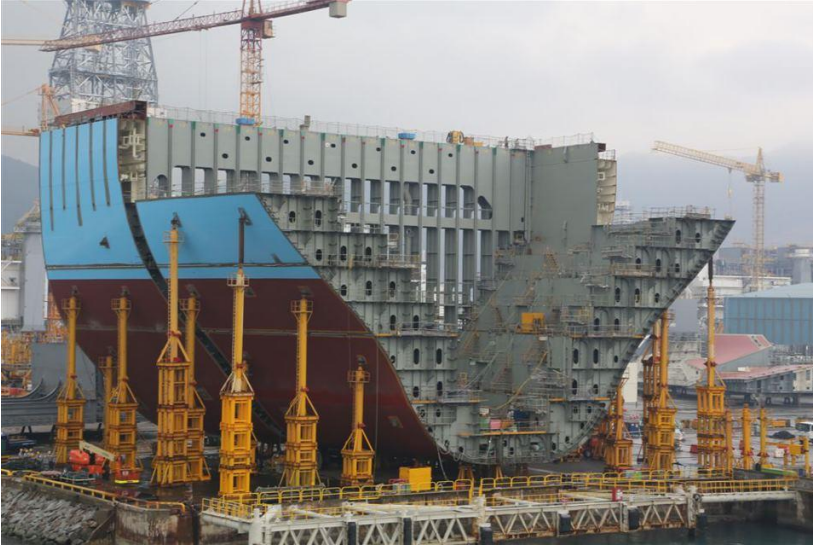
Figura 13 - Classe Triple-E - Visão do casco em “U” durante construção
