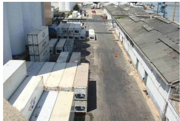
FIGURA 15 - Pátio de interligação (norte e sul) FONTE: CODERN
