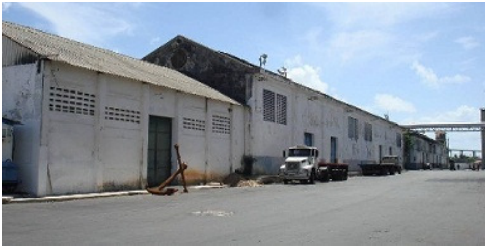
FIGURA 12 - FONTE: CODERN – visão geral dos armazéns e galpões
