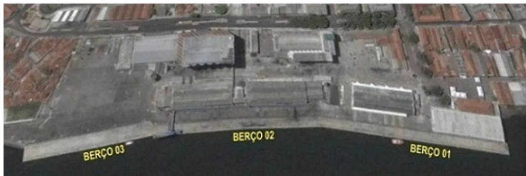
FIGURA 10 - FONTE: CODERN – berços 01, 02 e 03
