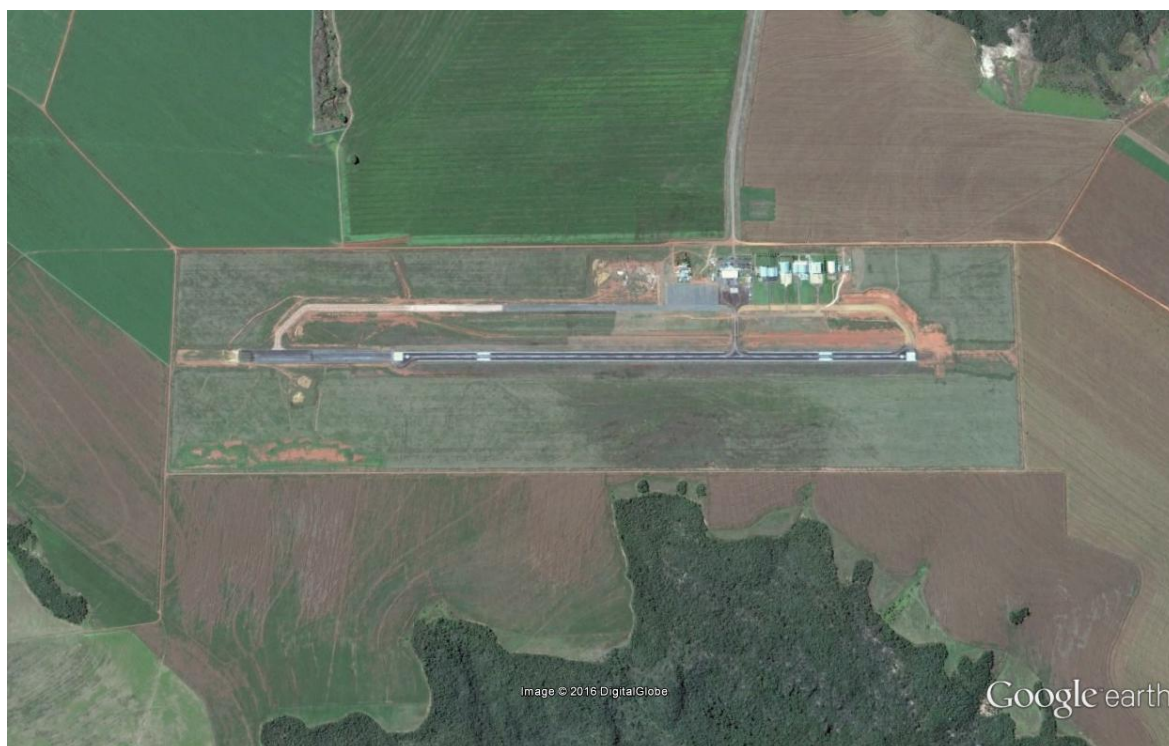
Figura 6 – Imagem via satélite do Aeroporto de Rondonópolis Fonte: Google Earth (2016). Elaboração: LabTrans/UFSC (2016)
