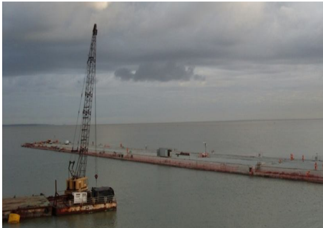
Figura 5 – Execução das obras de construção do Berço 100 no Porto do Itaqui/MA
