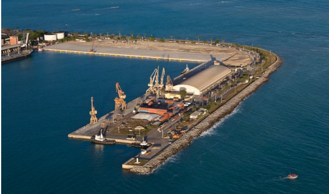
Figura 7 – Vista do cais para contêineres, concluído - Porto de Maceió/AL
