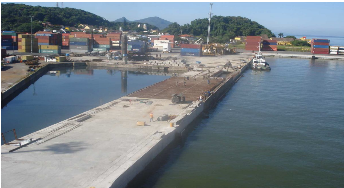
Figura 6 - Vista geral dos módulos 1 e 2 – Berço 201
