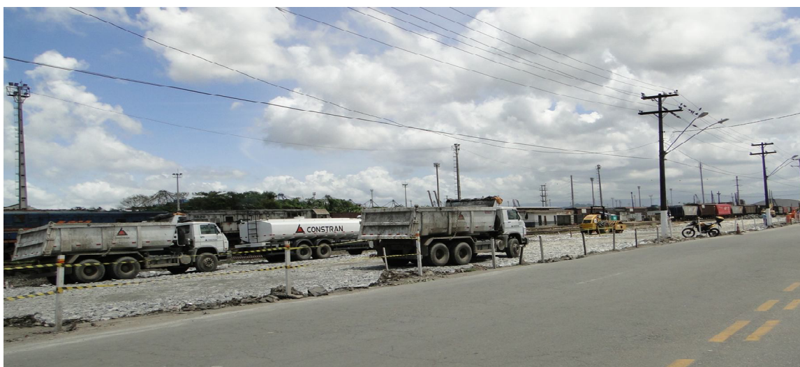
Figura 3 – Implantação da Av. Perimetral, margem esquerda, Porto de Santos/SP
