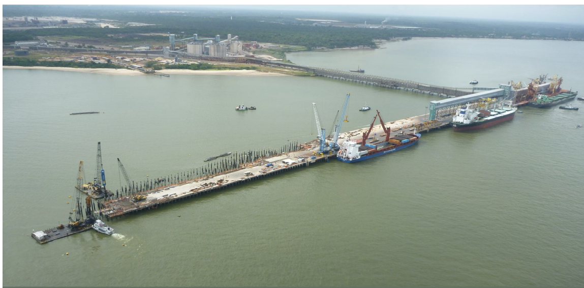
Figura 1 – Imagem aérea da ampliação em execução no Porto de Vila do Conde/PA
