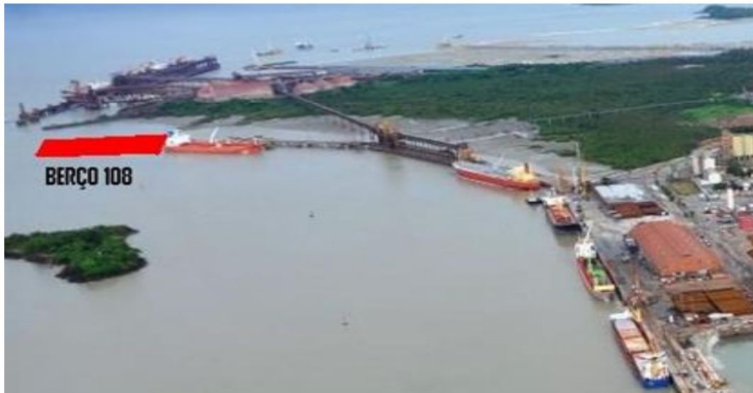
Figura 4 – Vista do local onde será construído o Berço 108 no Porto do Itaqui/MA
