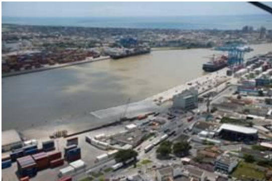
Figura 3 – Execução das obras de reconstrução no Porto Itajaí/SC
