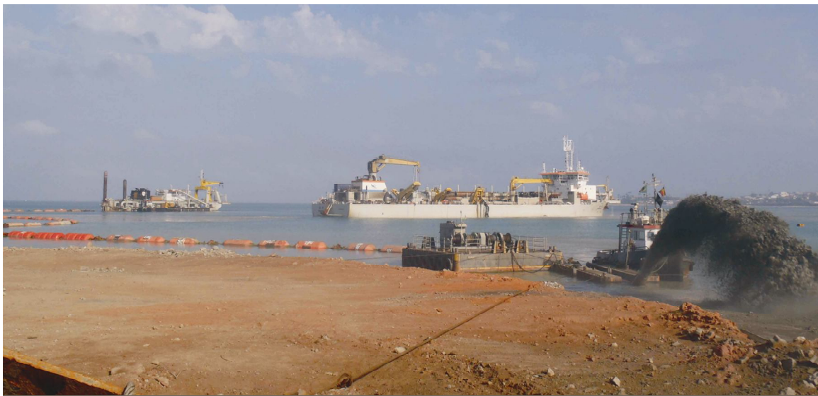
Figura 4 – Execução de PND em Salvador/BA
