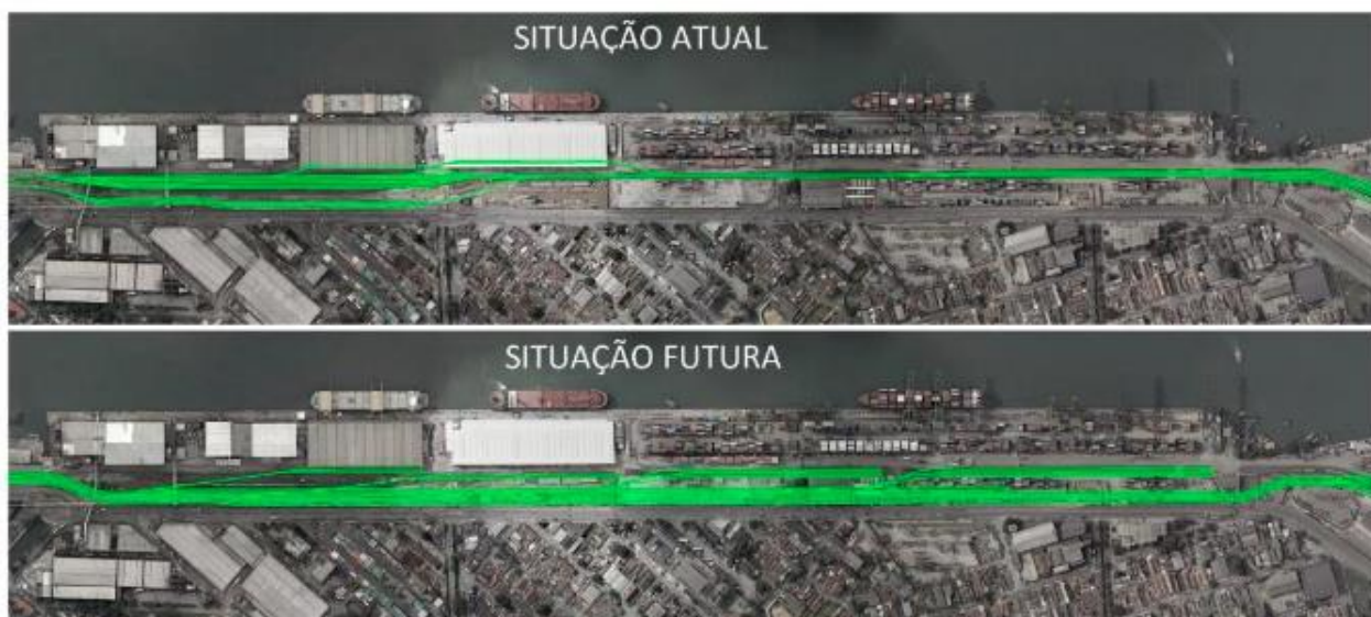
Figura 1: Obras ferroviárias região do Macuco. Fonte: SPA
