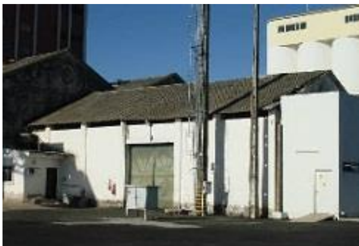
Fotografia 15 - Galpão nº 02 – lado do cais
