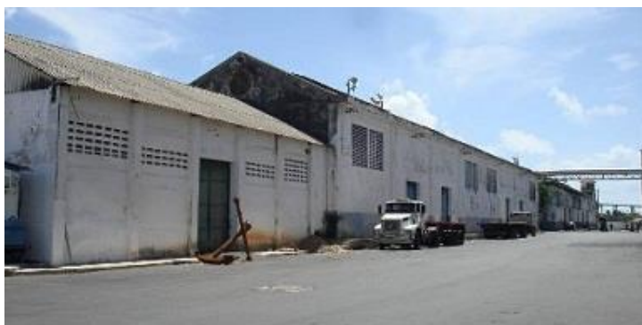
Fotografia 14 - Vista geral dos armazéns e galpões – em primeiro plano o galpão nº 02 e, em seguida, o armazém nº 02
