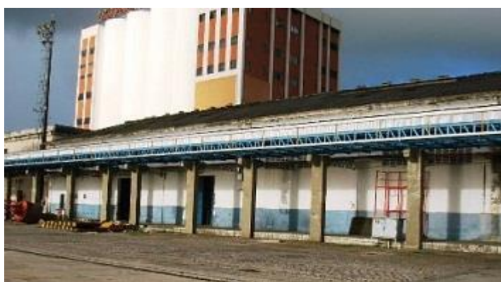
Fotografia 16 - Armazém nº 02 – lado do cais
