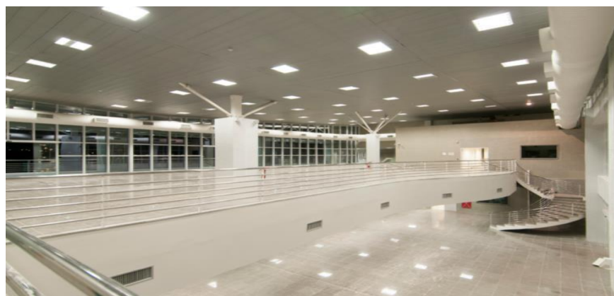
Fotografia 11 – Terminal Marítimo de Passageiros – 2º piso e escada de acesso
