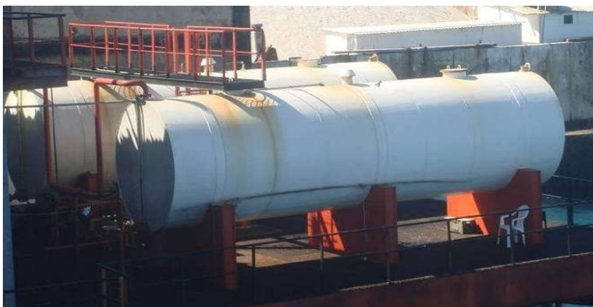
Imagem 27 – tanques de óleo Diesel
