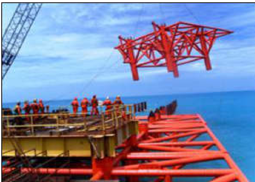
Imagem 9 – Estruturas metálicas tubulares do cais, quando da ampliação do Terminal
